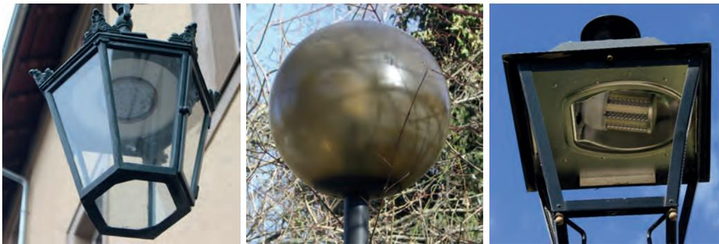
links: voll abgeschirmte Altstadtleuchte mit LED-Modul im Dach; Mitte: ineffiziente Kugelleuchte; rechts: Maiskolbenleuchtmittel als Retrofitlampe
